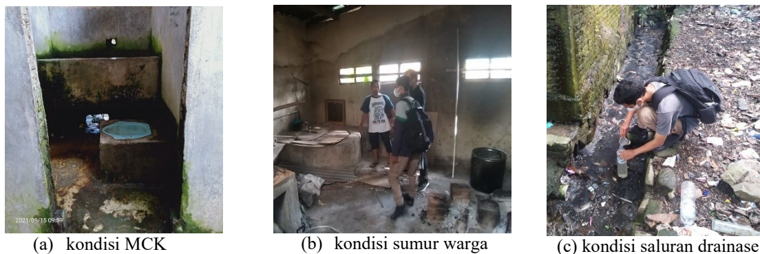
Gambar 2. Kondisi sarana sanitasi dan drainase
