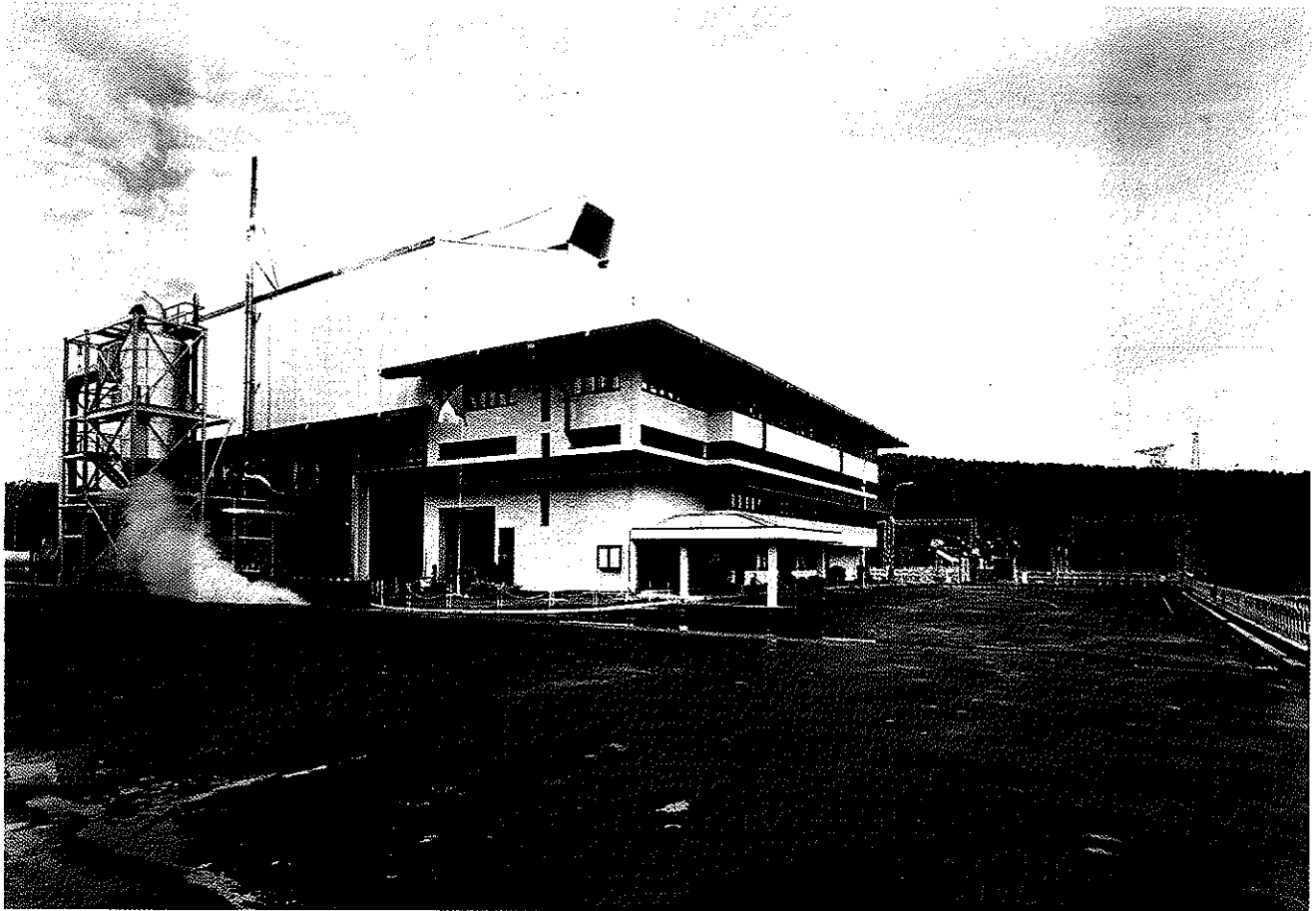
PLTP KAMOJANG 30 MW
