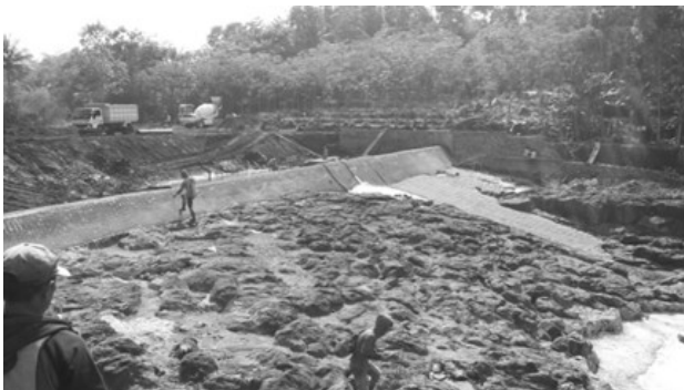
Gambar 6. Bendung Pleret (Sumber : Foto lapangan)
