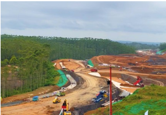
Gambar 1. Pembangunan Jalan di Ibu Kota Nusantara
