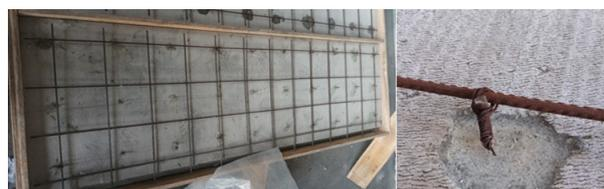
Gambar 3. Pemasangan wiremesh dan shear connector
