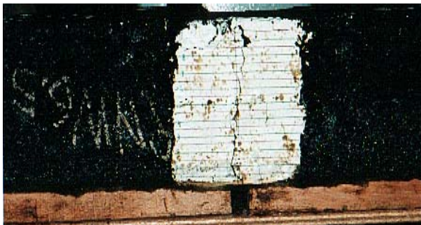
Gambar 3. Retakan pada beam RNW_S_6,5%
