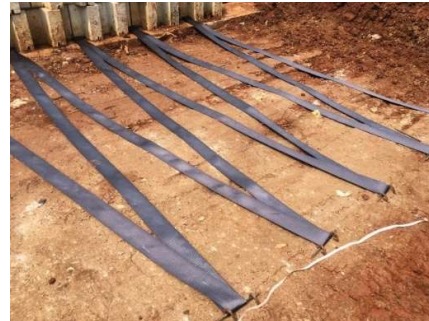
Gambar 5. Strip geosintetik dan konfigurasi pemasangan pada dinding
