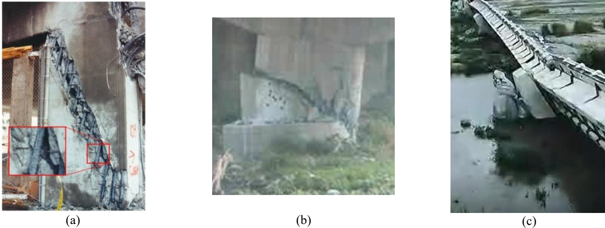
Gambar 1. Keruntuhan jembatan akibat kegagalan geser pada kolom pendek. (a) Nimitz Freeway (Mitchell dkk, 1991); (b) Jembatan Wu-shi (Buckle & Hwang SJ, 1999); (c) Jembatan Gaoliao (NCREE, 2022)
