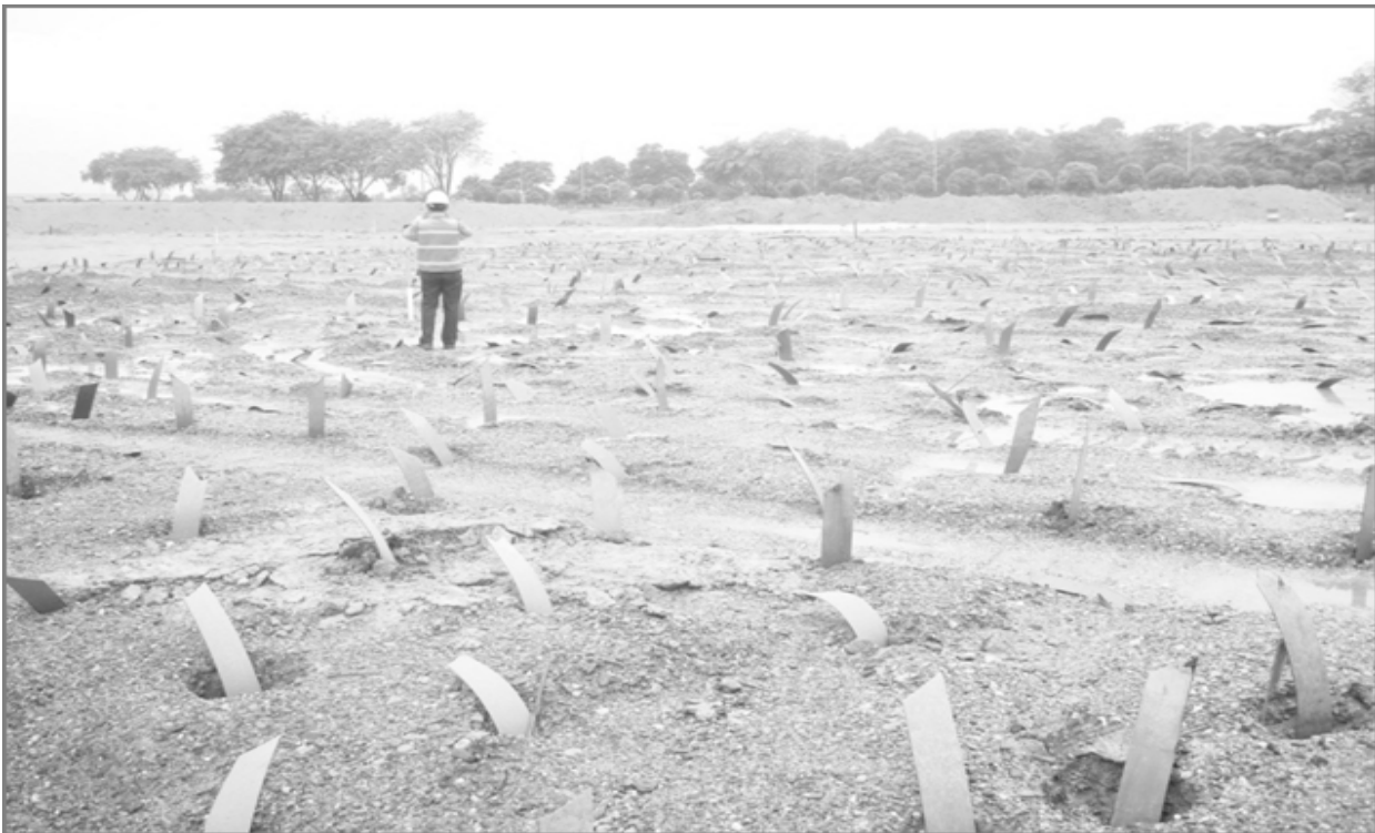
Gambar 5. Pemasangan Prefabricated Vertical Drain (PVD) pada lokasi timbunan
