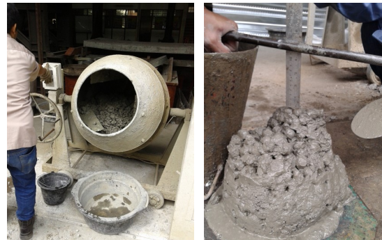
Gambar 2. Pencampuran material penyusun beton dan uji Slump.
