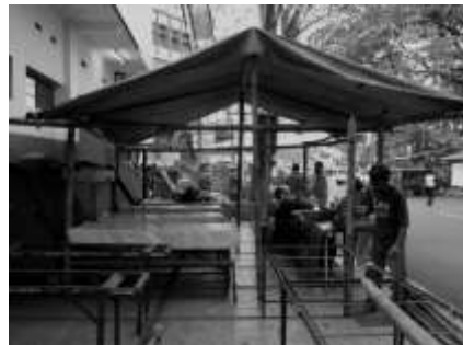
Konstruksi area makan telah selesai dan "konstruksi" dapur sedang disiapkan
