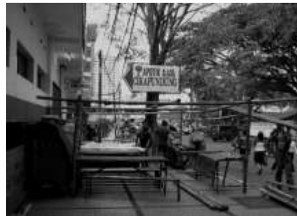
Proses konstruksi Lokasi : Jl. Cikapundung Barat (foto mengarah pada Jl. ABC)
