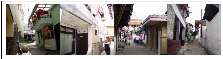
Gambar 4 Bangunan-Bangunan Sempadan Nol.
