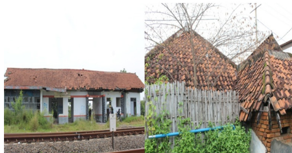
Gambar 5 Tinggalan bangunan stasiun dan rumah dinas Stasiun Waruduwur. (Sumber: Hasil Penelitian, 2018).
