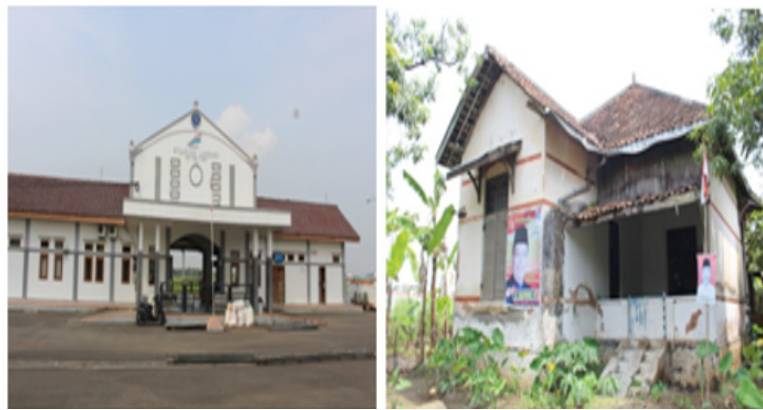
Gambar 13 Bangunan bekas Stasiun Losari dan bangunan Stasiun Losari Baru (Sumber: Hasil Penelitian, 2018).
